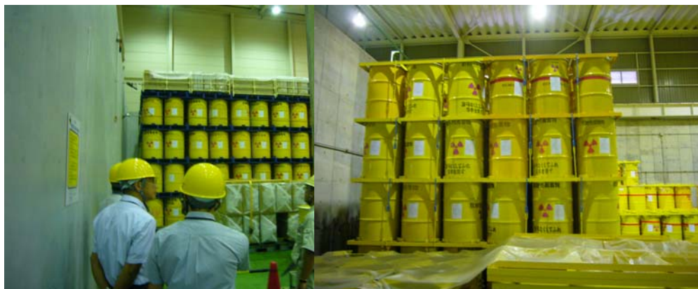
【固体廃棄物固縛（転倒防止）状況】
