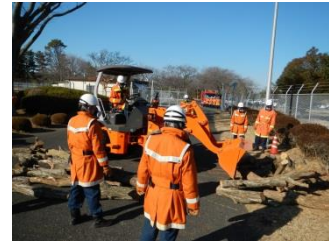
ミニホイールローダによる倒木撤去作業
