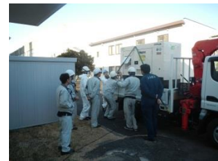
可搬型非常用発電機運搬接続作業
