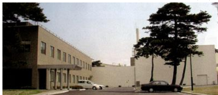
事業所風景 左側建物が事務棟、奥側が新分析棟
