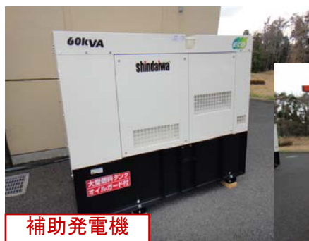
災害時用発電設備 ●補助発電機 ●タンクローリー車 「大洗研究開発センター等で使用電源及び非常用電源が使用できない場合に備えた移動用発電設備です。」
