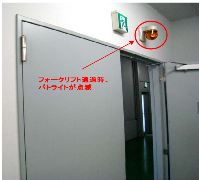
フォークリフトの通路走行 検知用赤外線センサとパト ライト
