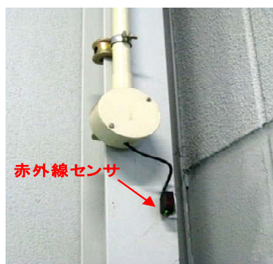
フォークリフトの通路走行 検知用赤外線センサとパト ライト
