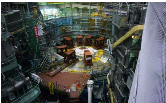
JT-60 架台の解体現場
