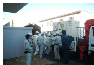
可搬型非常用発電機運搬接続
