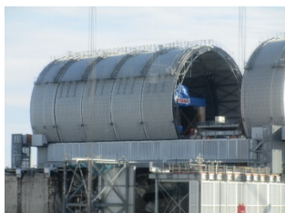
3号機原子炉建屋 燃料取り出し用カバー
