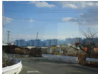
多核種除去処理水 貯蔵用タンク
