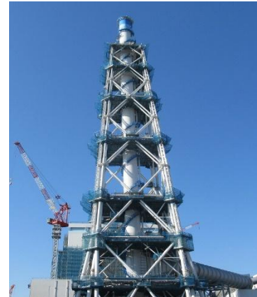
主排気筒耐震補強 工事の状況
