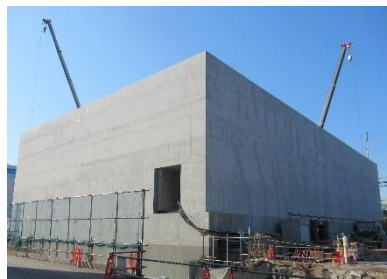
常設代替高圧電源装置 置場設置工事の状況
