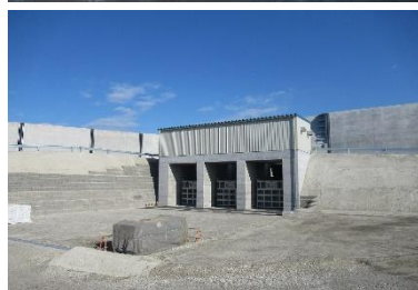
防潮堤設置工事の状況
